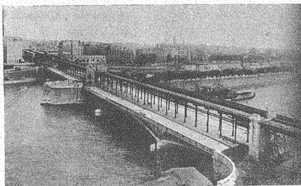
Fig. 6. — Viaduc de Passy.
