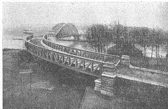
Fig. 8. — Travées hélicoïdales du quai de la Râpée.
