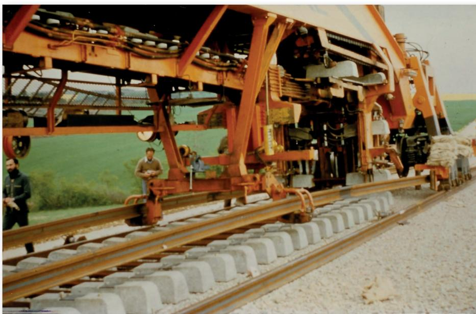
*Illustration A : Pose automatisée de traverses et de voies (fin 1979).*
